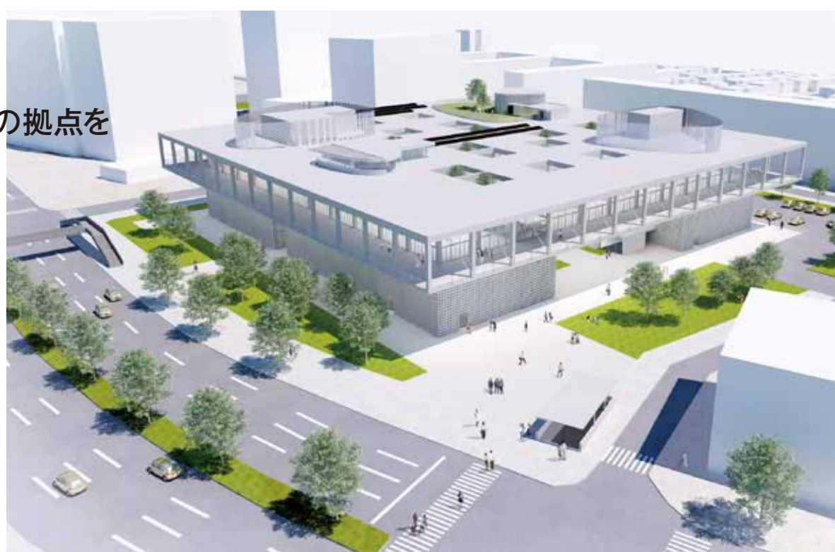
鳥瞰パース 名古屋の街に開かれた大学。大きな屋根が浮いているような建築。構造素材は高強度、長寿命のプレキャストコンクリート。
